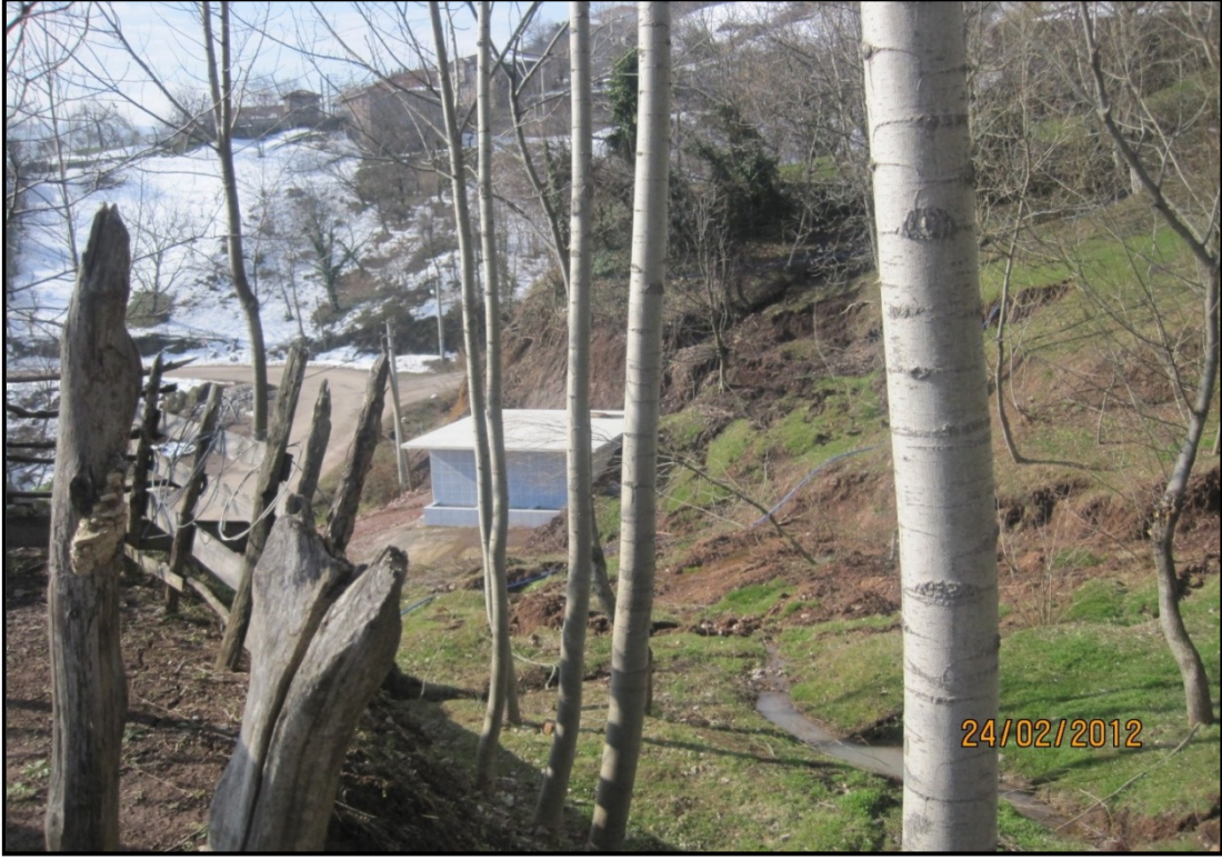
Şekil 10. Hasaney köyünde eski heyelan alanı üzerinde oluşan yeni heyelan Figure 10. New landslide developed on the old landslide area in Hasaney village
