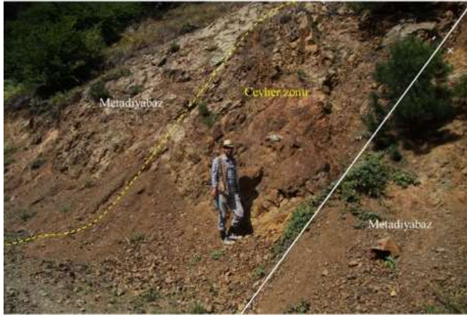
Şekil 8. Fındıklıyar Cu±Zn cevherleşmesinin genel görünümü (Güneydoğudan Kuzeybatıya Bakış)
