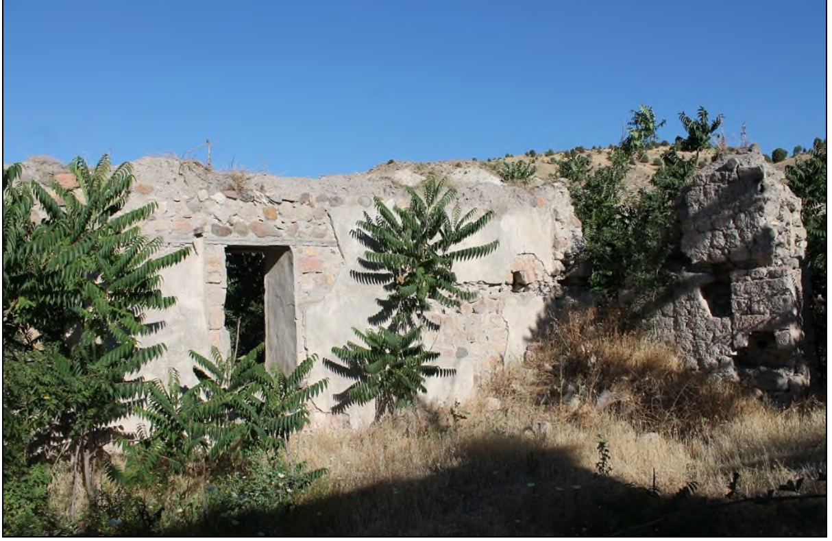
Resim 5. Derbentçik Camii batı duvarı içten görünüm fotoğrafı (2016).
