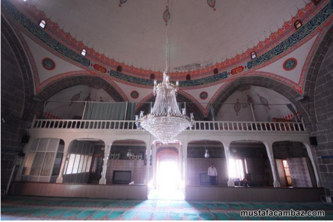
G.3- Narmanlı Camii ahşap restorasyon öncesi ahşap kadınlar mahfilinin beyaz boya ile boyanmış hali. ( http://www.mustafacambaz.com/details.php?image_id=38757&sessionid=5b489b469aabb )
