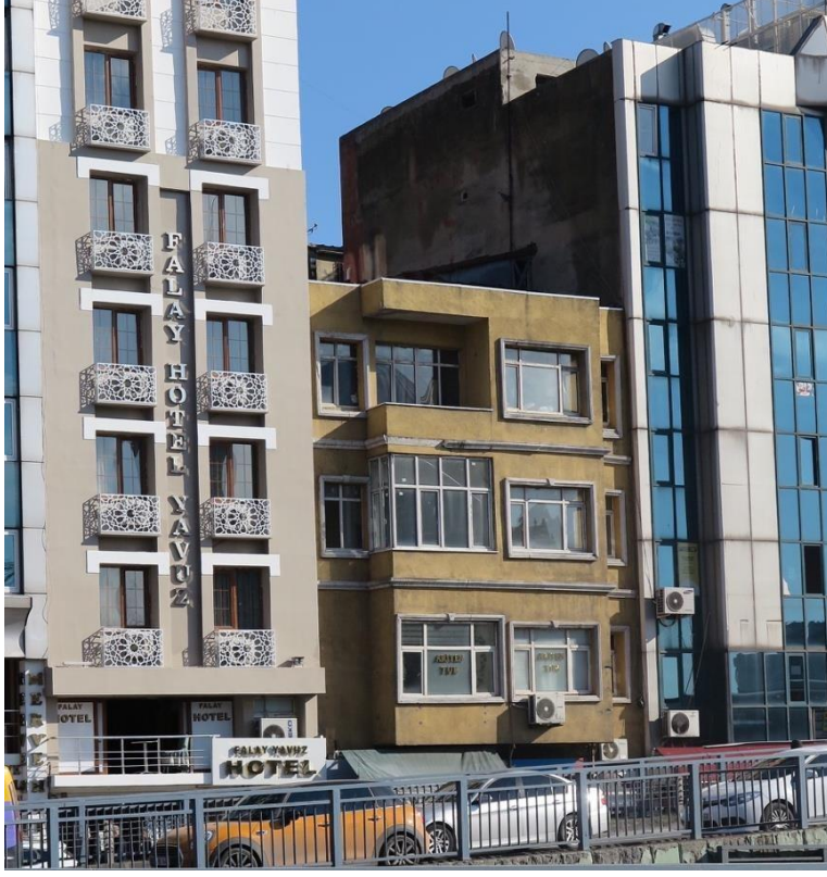
G. 4:: Hasan Bey Apartmanı. (Müjde Dila Gümüş, 2018)
