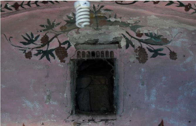
G.7: Hacı Nazır Türbesi, güney cephe yukarı kesimdeki süsleme
