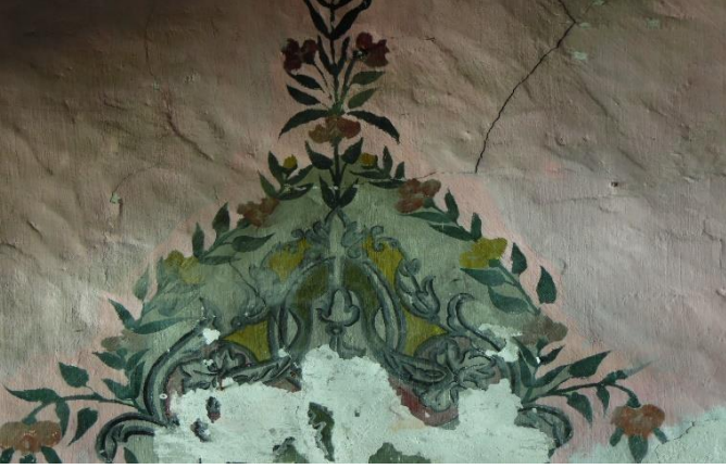
G.9: Hacı Nazır Türbesi doğu cephe detay
