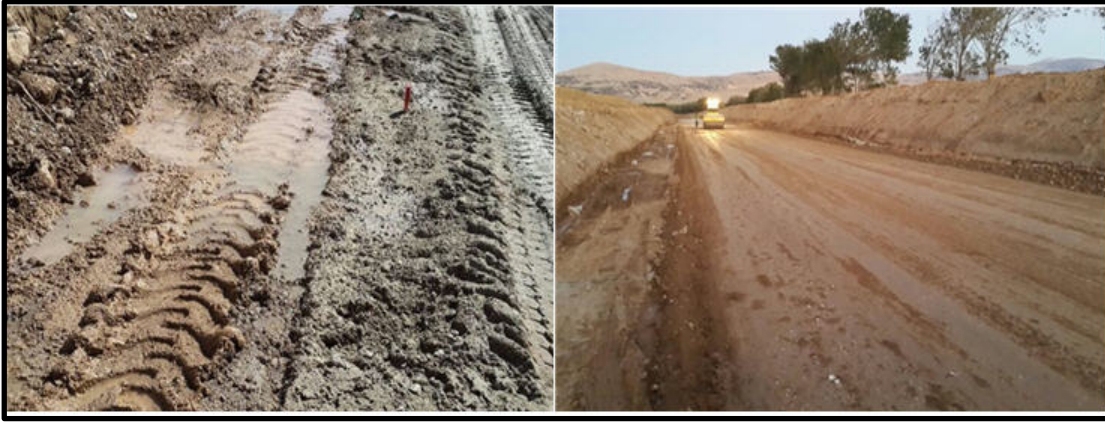
Görüntü 2: Denizli-Afyonkarahisar Bozkurt-Dinar Demiryolu Hat Yenileme Projesi iyileştirme öncesi ve sonrası zemin tabakasının ve yeraltı seviyesinin görünümü.
