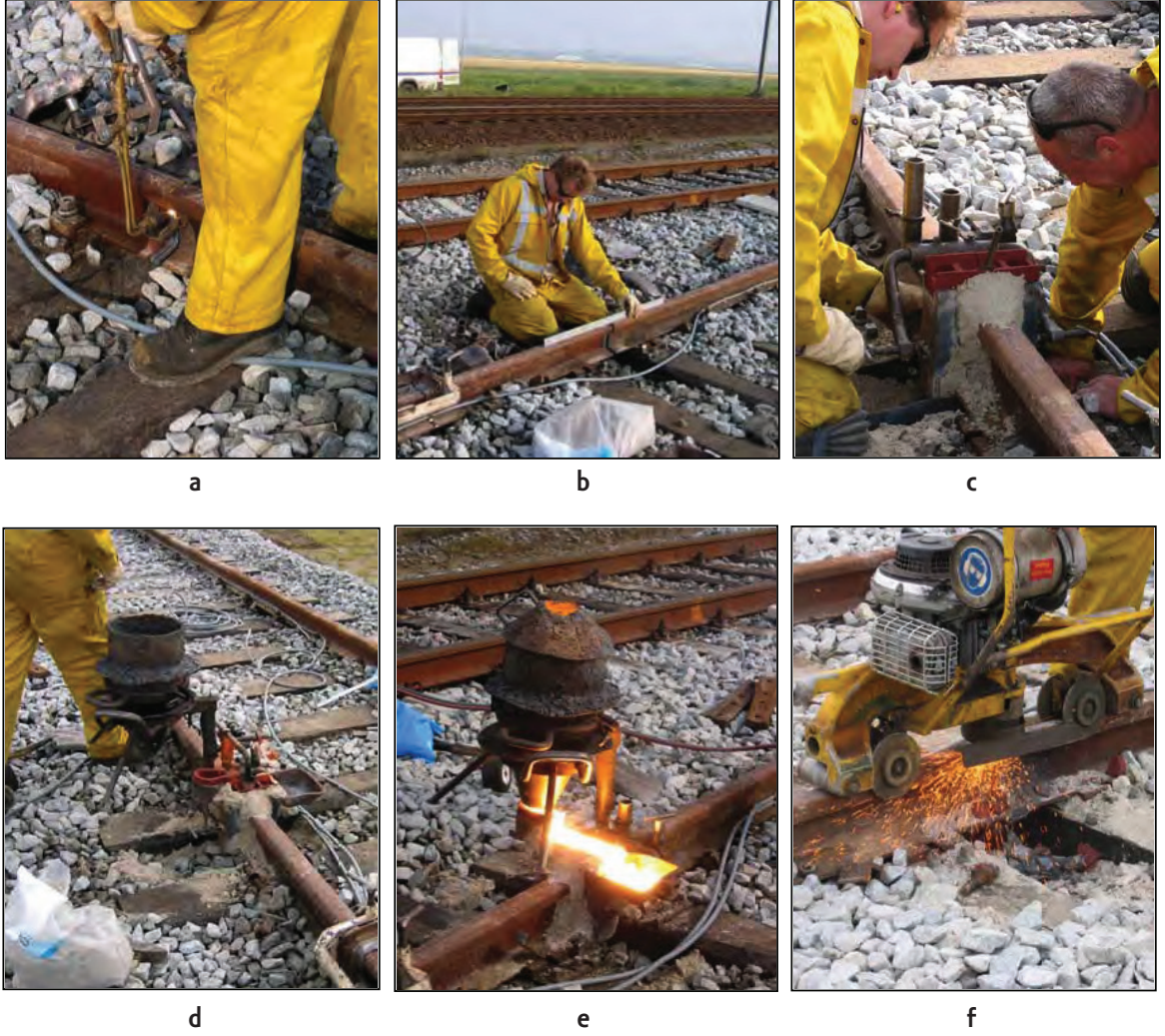
Şekil 4. Alüminotermik kaynak süreci.
