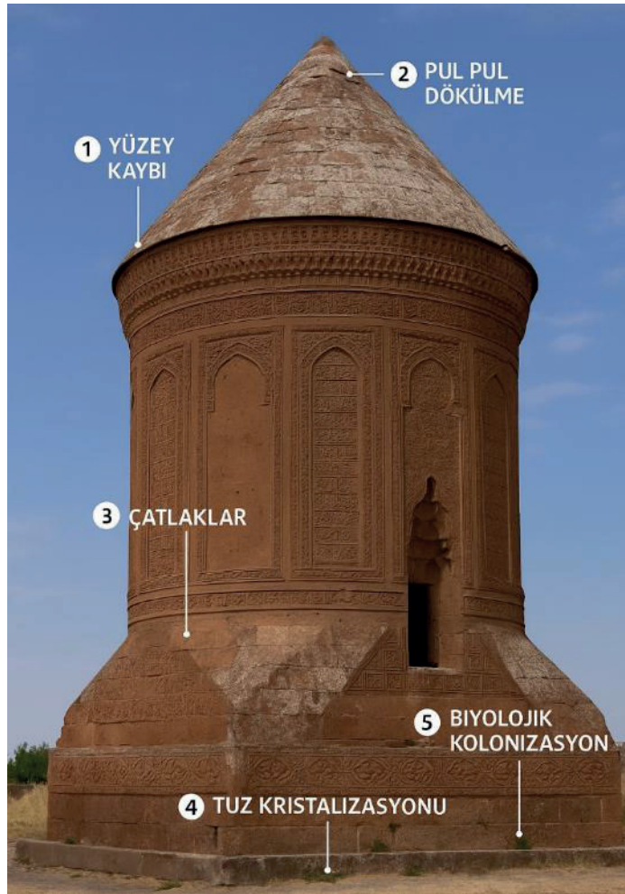
Şekil 7. Ulu Kümbet'te gözlenen başlıca bozunma türleri.
