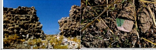
Resim:19 Çorum/Merkez-Cemilbey (Çorak) Köyü. Ören Yerinde Caminin İçerisinde Yapılan Kaçak Kazılar Sonucunda Yıkılan Mihrap Duvarından Görünüm (18.Ağustos 2017).
