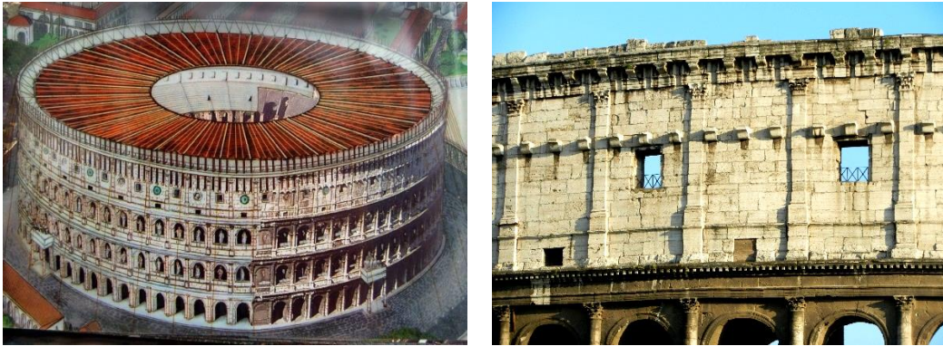
Şekil 3. Colosseum'un çatı örtüsü (16) ve direklerin bağlandığı taş konsollar (foto: Mustafa Kavraz)
