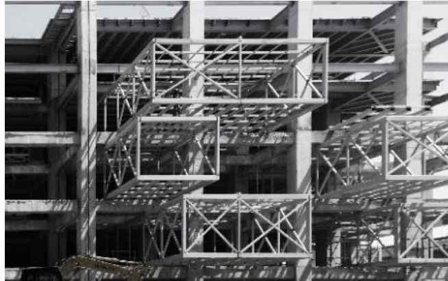
Şekil 8. İRHM taşıyıcı sistem ve galerilerin inşaa aşaması (Arkitektuel, n.d.)
