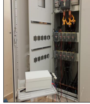
(a) İzleme cihazının ölçüm noktasına bağlantı şekli.
