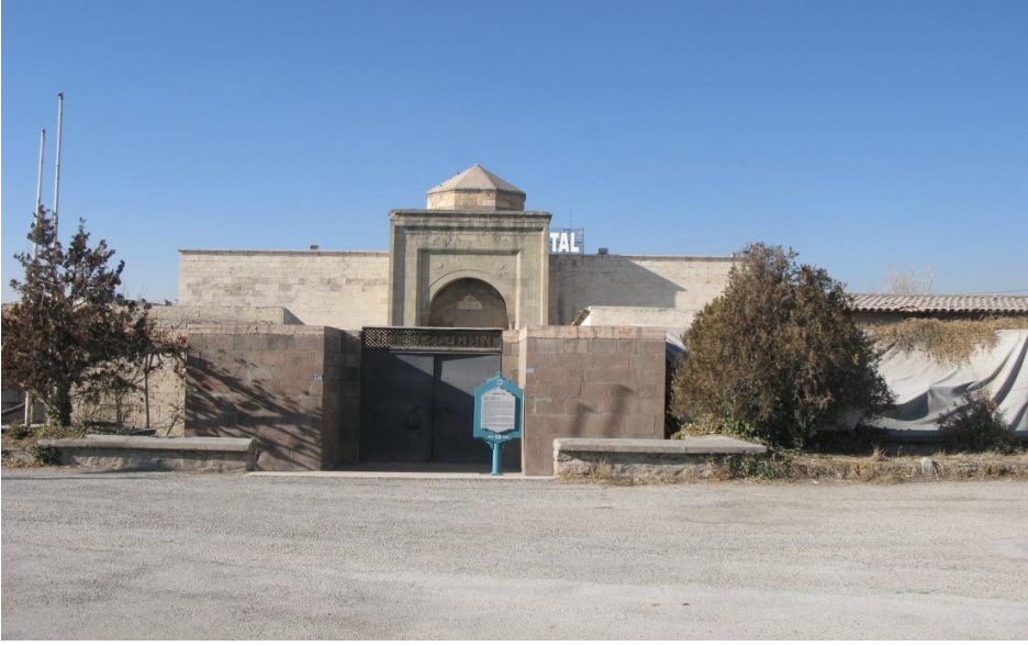
Resim. 2. Horozlu Han'ın ön (doğu) cephesi.
