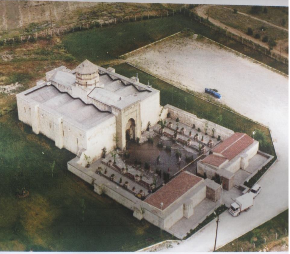
Resim.10. Yapının üstten genel görünüşü.
