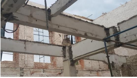
Şekil 11. Yapı içerisinde daha önce imal edilmiş olan betonarme ara kat
