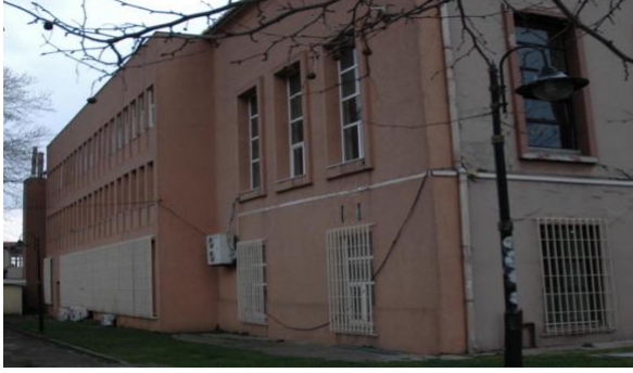
Şekil 4. Yapının kısa kenar doğrultusu görünümü ve ilave betonarme yapı
