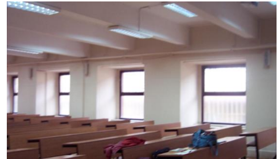
Şekil 9. Yapı içerisinde yer alan amfi mahalindeki ilave betonarme kirişler
