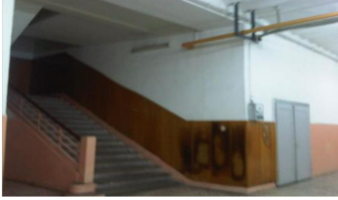
Şekil 10. Yapıya sonradan ilave edilmiş olan merdiven bloğundan birine ait görünüm
