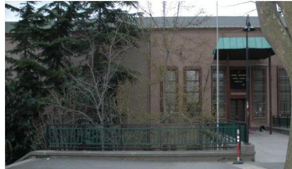
Şekil 2. Yapının kısmi ön cephe görünümü
