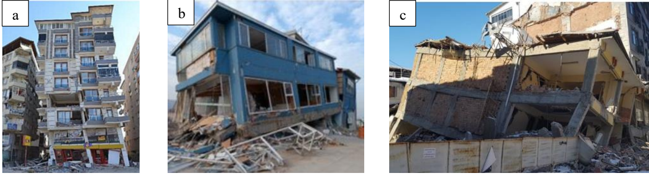
Şekil 1. 6 Şubat 2023 Kahramanmaraş Depreminde Yumuşak Kat Düzensizliği İle Hasar Gören Yapılar, a. (Ozturk vd., 2023), b. (Avcil vd., 2024), c. (Atar vd., 2024)
