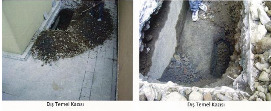
Şekil 6. Binanın dışından ve içinden açılan temel çukurları
