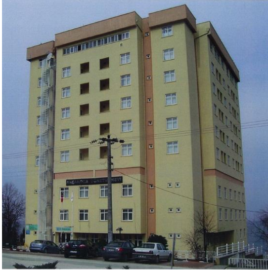
Akçakoca Öğretmen Evi Güney ve Doğu Cephesi
