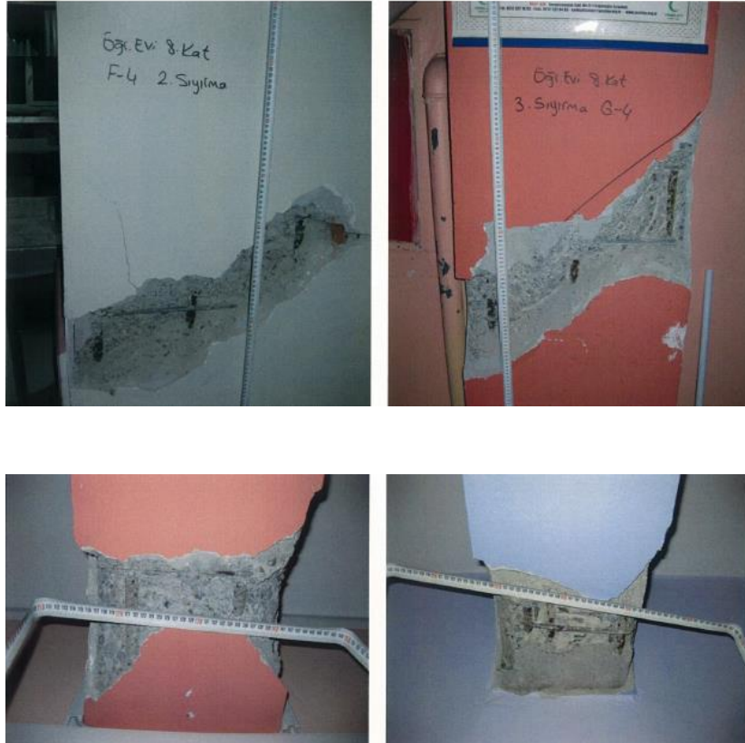
Şekil 3. Kolon (2 adet) ve kirişlerde (2 adet) sıyırma yapılması
