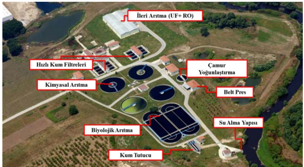
Şekil 1. Bursa Organize Sanayi Bölgesi Su Üretim Tesisi.
