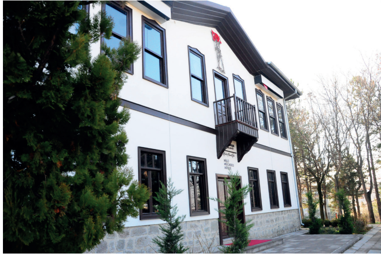
Şekil 23: Kuzeybatı Cephe Günümüz Genel Görünümü
