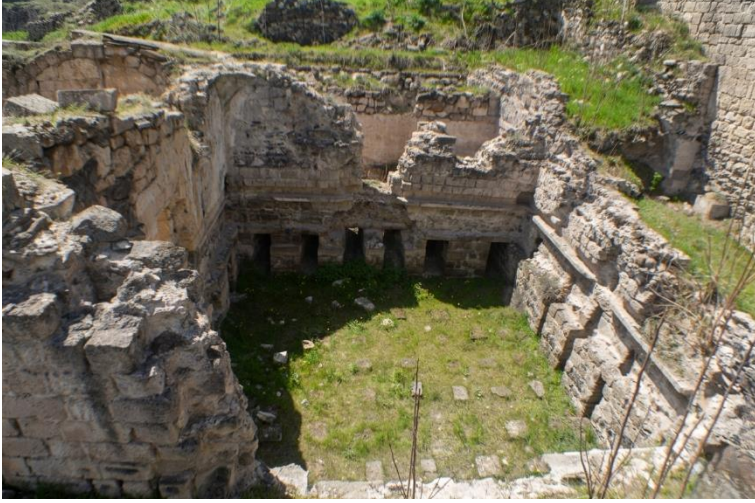
Görsel 11. Nevşehir Rum Hamamı, Sıcaklık.
