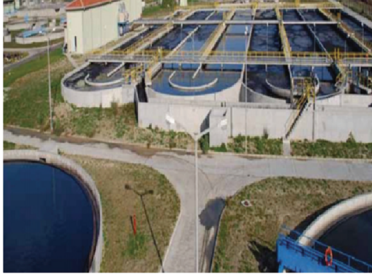
Şekil 3. Bölgede ki atıksu arıtma tesislerine ilişkin örnek bir tesis [4]
