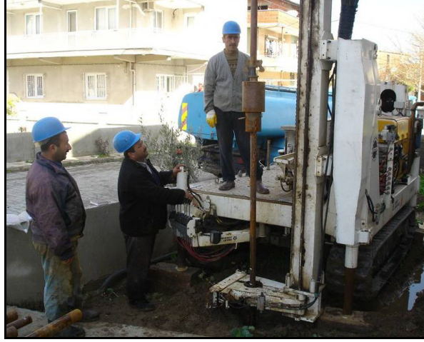
Şekil 5. Çalışma alanında SPT sondaj çalışması
