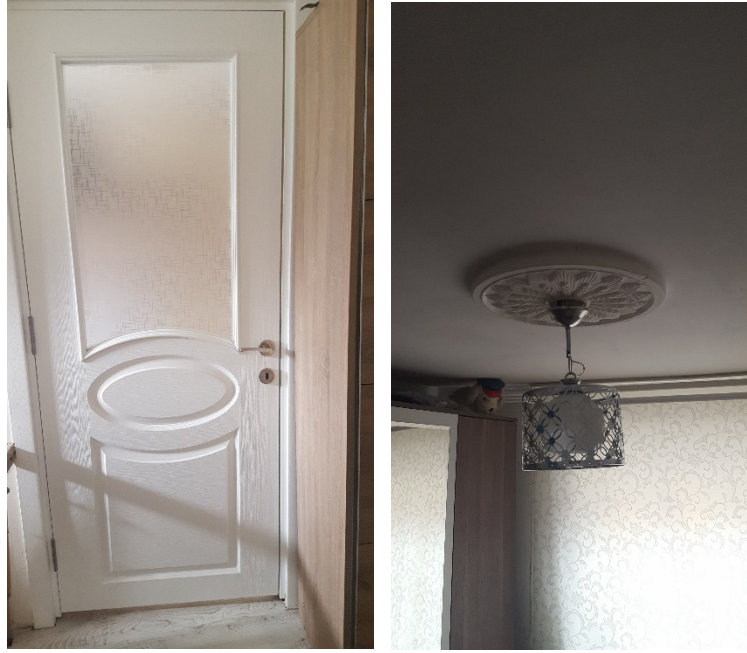
Şekil 10. Yenilenen kapılar ve kartonpiyer uygulaması
