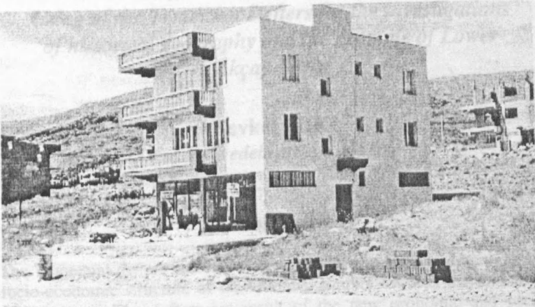
Foto 4B: Atatürk mahallesindeki yeni yerleşim alanındaki yeni yapılmakta olan inşaatların alt katları inşaat malzemesi satıcıları tarafından Değerlendirilmektedir
