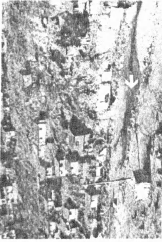
FOTO 5.b: Kavaklıdere vadisinde tahrip edilen konutlar. Akış yönü, beyaz okla gösterilmiştir. Fotoğraf Eyka 2 konularının yakınından alınmıştır.
