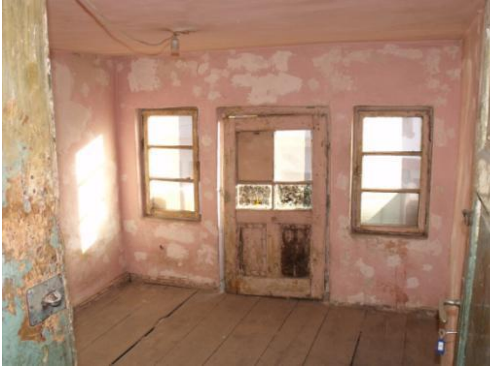
Foto-23: 2. Kattaki (Çatı Arası) odalardan görünüşü
