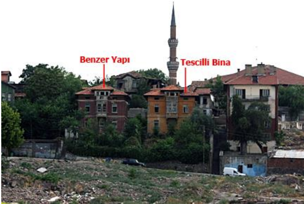
Foto-2: İncelenen yapı ve yanındaki benzer bina
