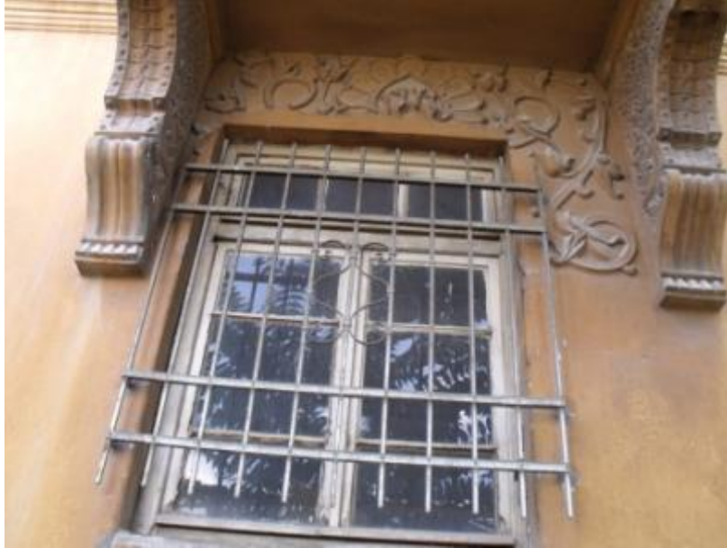
Foto-7: Kuzeydoğu (arka) cephe çıkma konsolları ve bezeme
