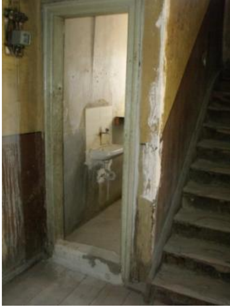
Foto-22: 2. Kattaki (Çatı Arası) odalardan görünüşü
