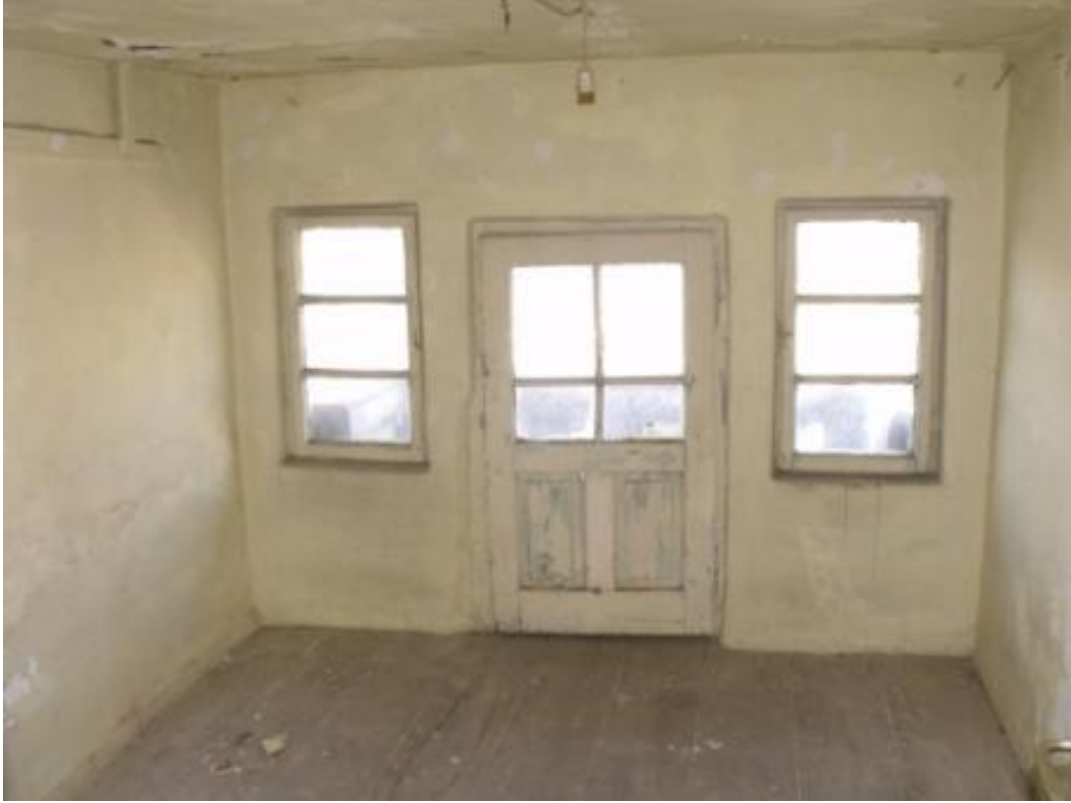
Foto-24: 2. Kattaki (Çatı Arası) odalardan görünüşü
