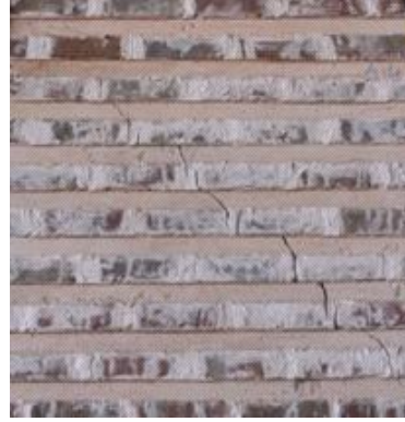
Şekil 11. Deney sonucu mekanizma durumu
