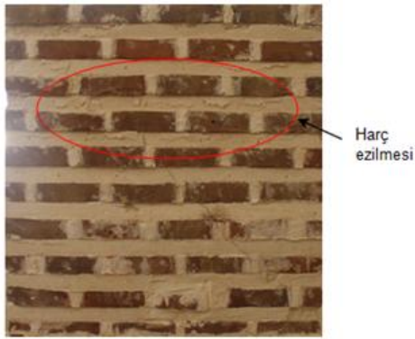
Şekil 15. Deney sonucu mekanizma durumu
