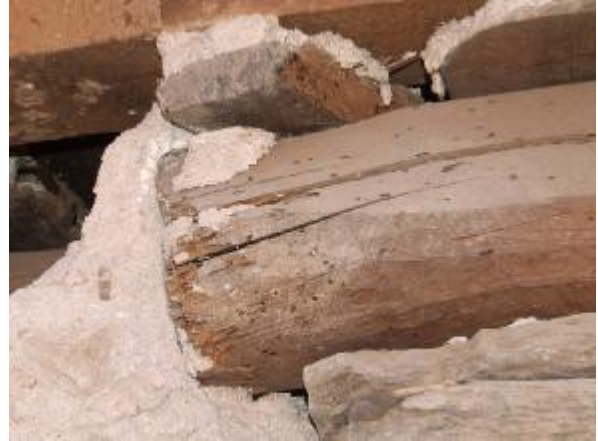
Şekil 13. Yakından bakıldığında ahşap elemanlardaki bozulmalar oldukça net biçimde görülmektedir. Sol taraftaki fotoğraftaki elemanın kesit boyutlarındaki küçülme de rahatlıkla gözlemlenebilmektedir.
