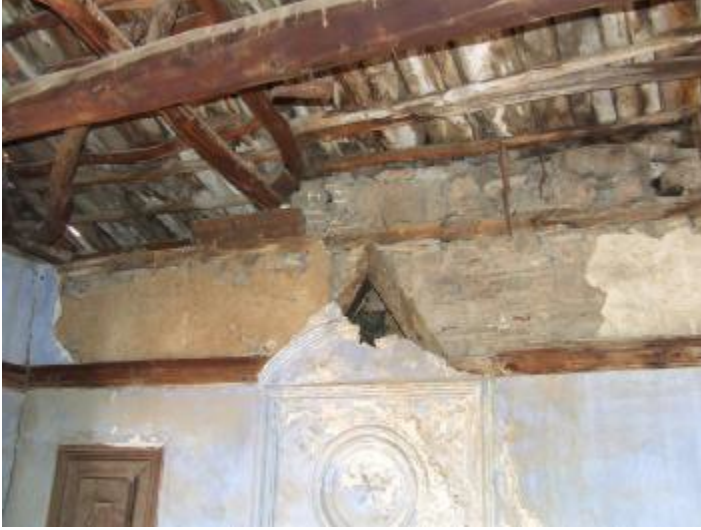
Şekil 11. Ahşap elemanlarda mantar etkisiyle görülen renk değişimleri
