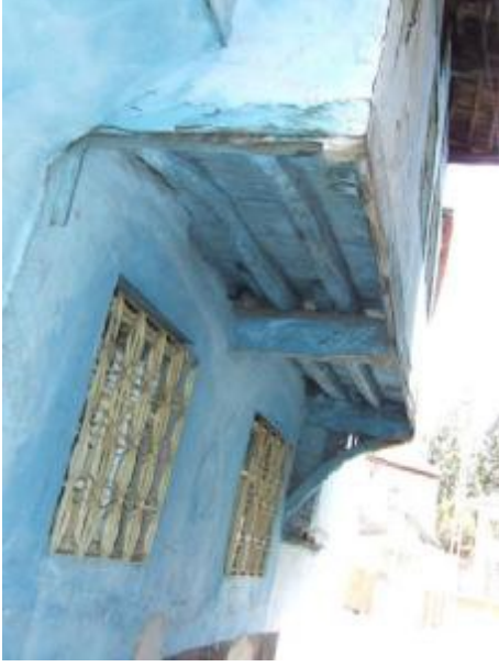
Şekil 7. Ahşap çıkma örneği
