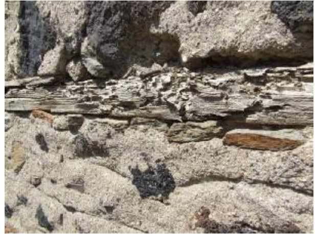
Şekil 17. Bu örnekte ise basit bir bahçe duvarı görülmektedir. Yakından bakıldığında ahşap hatıllardaki bozulmalar ve yer yer duvarda oluşan çökmeler görülmektedir. Duvarda bozulmaların olduğu yerlerde ise büyük ihtimalle ev sahibinin kendisi tarafından uygulanan çözüm ise yıkık bölümün tuğla ile doldurulması olmuştur.
