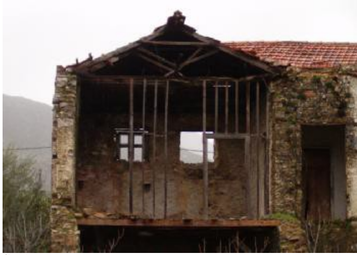
Şekil 5. Kargir yapıda ahşap döşeme kirişleri, ahşap çatı ve ahşap lentolar
