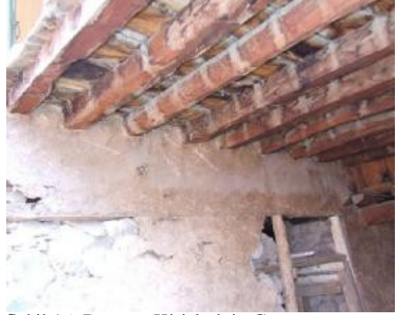
Şekil 16. Döşeme Kirişlerinin Görünümü
