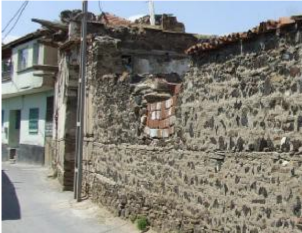
Şekil 17. Bu örnekte ise basit bir bahçe duvarı görülmektedir. Yakından bakıldığında ahşap hatıllardaki bozulmalar ve yer yer duvarda oluşan çökmeler görülmektedir. Duvarda bozulmaların olduğu yerlerde ise büyük ihtimalle ev sahibinin kendisi tarafından uygulanan çözüm ise yıkık bölümün tuğla ile doldurulması olmuştur.
