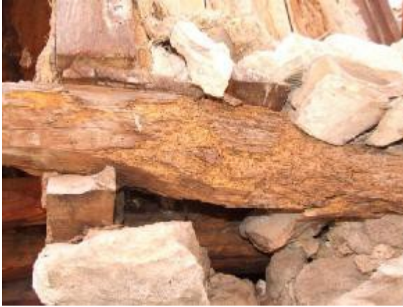
Şekil 13. Yakından bakıldığında ahşap elemanlardaki bozulmalar oldukça net biçimde görülmektedir. Sol taraftaki fotoğraftaki elemanın kesit boyutlarındaki küçülme de rahatlıkla gözlemlenebilmektedir.
