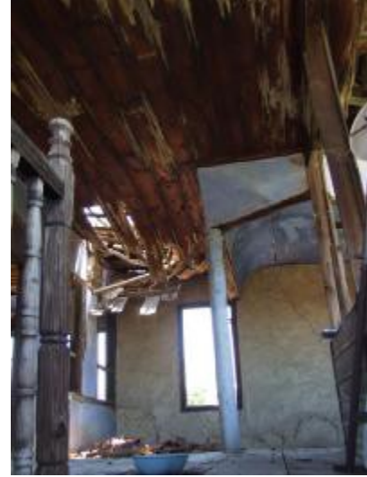
Şekil 12. Çürüyen ve taşıyıcılık özelliğini yitiren döşeme elemanları
