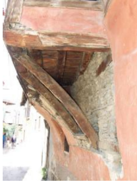
Şekil 8. Çıkmayı destekleyen diyagonal elemanlar
