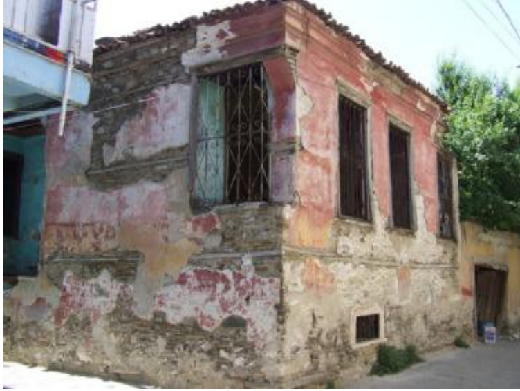
Şekil 3. Kula'dan küçük bir kargir yapı örneği. Tüm dış duvarlar moloz taş örgüsü ve yaklaşık 50 cm. yapının bir bodrum katı mevcut. Sıvanın döküldüğü yerlerde ise ahşap hatılları görmek mümkün. Köşedeki birleşim detayı hatılların üst üste bindirilmesiyle oluşturulmuş.
