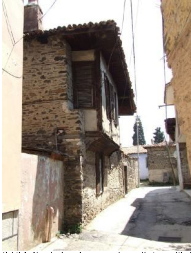
Şekil 1. Kargir duvarları taş malzeme ile inşa edilmiş Geleneksel Türk Konutu, Örneği–Ahşap Hatıllar, ahşap çıkma ve çatı rahatlıkla gözlemlenmektedir (Kula).
