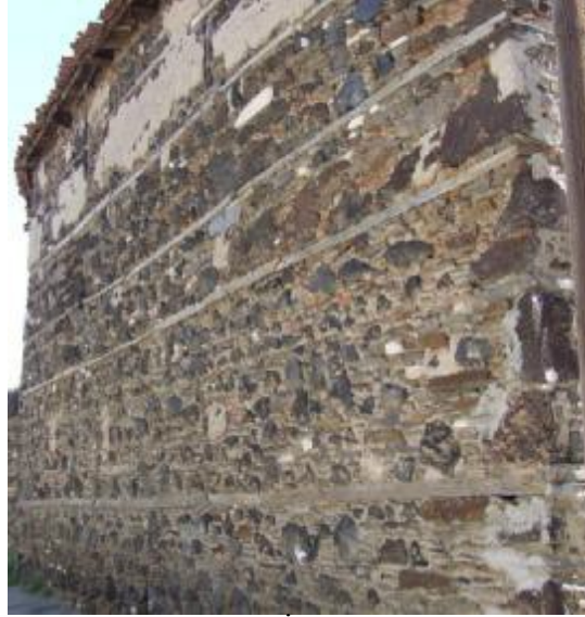
Şekil 2. Kargir duvar İçindeki Ahşap hatıllar
