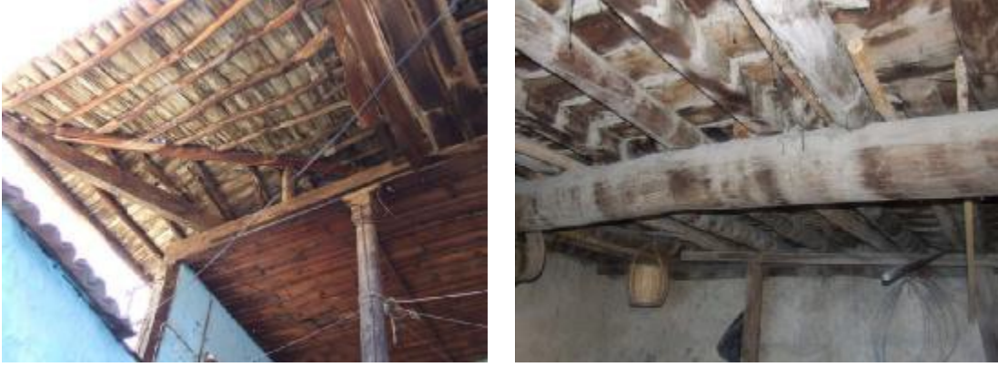
Şekil 6. Resimlerde görüldüğü gibi çoğu zaman kullanılan ahşap elemanlar basitçe işlenmekte ve bazen de yuvarlak kesitli olarak kullanılmaktadır.
