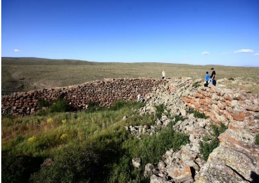
Foto 4. Kapıkaya Kalesi 1 Sur Duvarlarından Bir Görünüm
