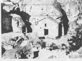
Res. 1) No. 5 Sıvışlı Kilise, Batı Cephe
