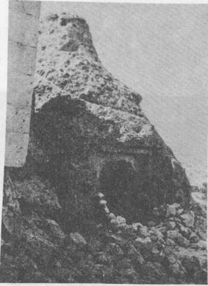
Res. 5: No. 4a (Sümer Kilise 1) Güney Cephe
