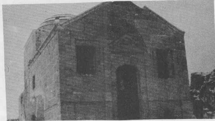
Res. 19: No. 20 (Yüksek Kilise/Aziz Mamas Manastırı), Kilise Kuzeybatı Cephe
