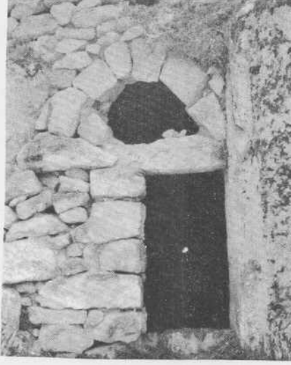
Res. 26: No. 13 (Üçlü Kilise) Batı Cephe, Giriş
