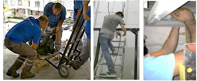
Şekil 9. Makine taşıma, karkas ve kabin montajına ilişkin duruşlar
