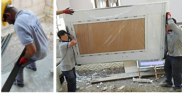
Şekil 8. Ray, kabin tabanı ve panellerinin taşınması
