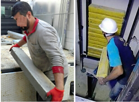
Şekil 7 Karşı ağırlıkların kuyu yakınına ve kuyu içine taşınması
