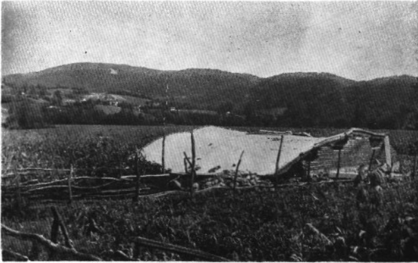
Foto 4 - İnpiri ile Ahatlar arasında (Amasra doğusu) çökmüş olan bir ev. Dikey komponent.
