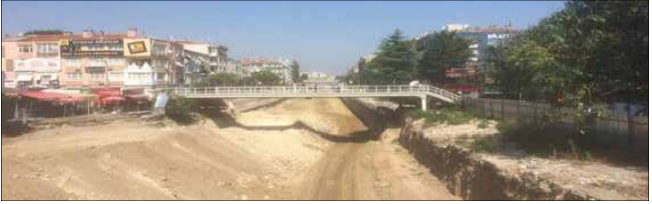
Şekil 3. Bakırköy'deki Sirkeci-Halkalı Banliyö Tren Yolundaki Yenileme Çalışmaları
