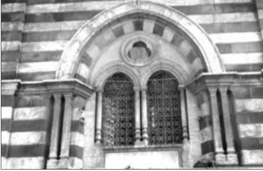
Şekil 8: Giriş Kapısının Üst Bölümü
