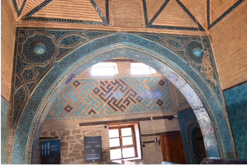
Fotoğraf 16. Eyvan kemeri görünümü ve doğu duvar görünümü
