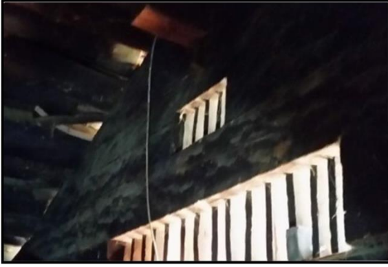
Şekil 8. Ahşap Yığma Sistemi ile Yapılan Konutların Havalandırma Boşlukları
