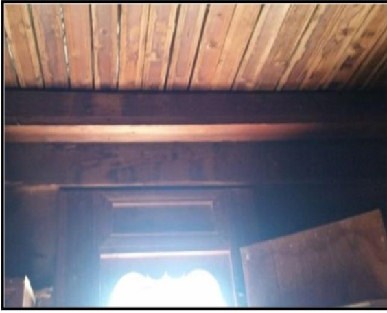
Şekil 12. Izgara Sistemi ile Yapılan İç Hayat Tavanı
