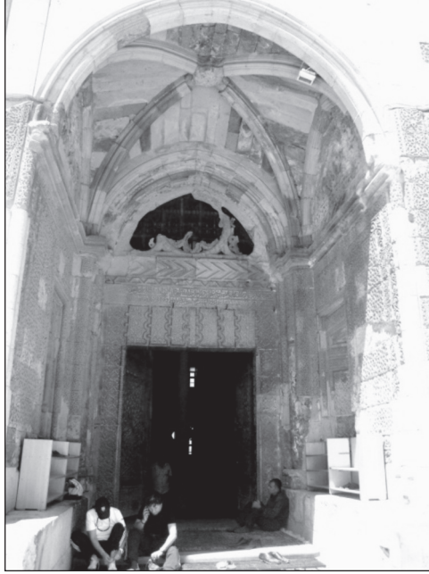
Fotoğraf 9. Niğde Sungur Bey Camii, doğu cephe, taç kapı
