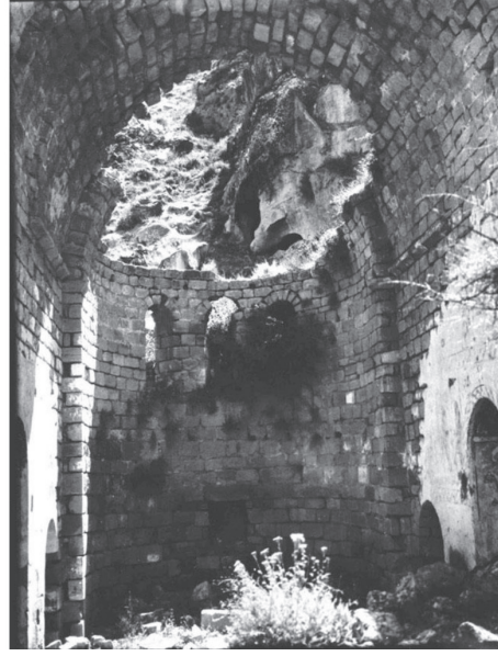
Resim 24. Doğu Haç Kolu Beşik Tonozu, Batıdan Bakış (www.gerty.ncl.ac.uk/)
