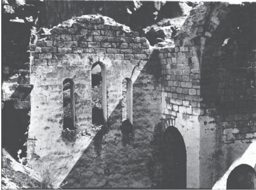
Resim 22. Kubbeye Geçiş Sağlayan Pandantifler, Güneybatıdan Bakış (Ramsay ve Bell, 1909, s. 420)
