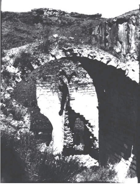
Resim 23. Doğu Haç Kolu Beşik Tonozu, Doğudan Bakış (Ramsay ve Bell, 1909, s. 423)
