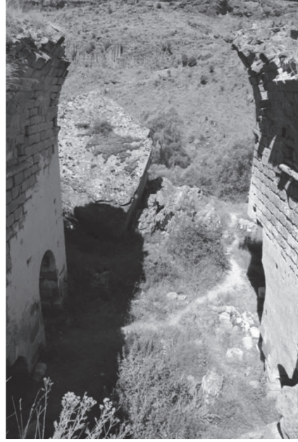
Resim 11. Güneydoğu ve Kuzeydoğu Köşe Odaları, Doğudan Bakış (Boleken, 2010)
