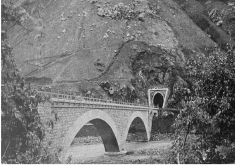
Fevzipaşa-Diyarbakır Demiryolu hattı (Bakır Hattı) üzerinde inşa edilen Ergani Madeni İstasyonu ve yapılan köprü ile tünel
