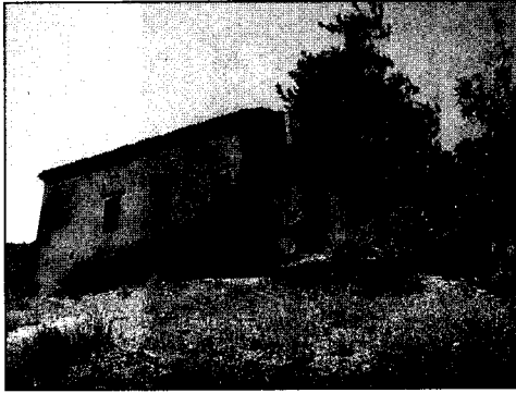
Res. 1) Şirince, Kilise 1 Kuzey Cephe
