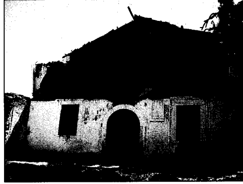
Res. 2) Şirince, Kilise 1 Batı Cephe
