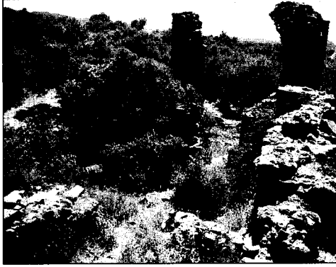
Res.37) Karıncalı Yokuş Mevkii Yapı Battıya Bakış
