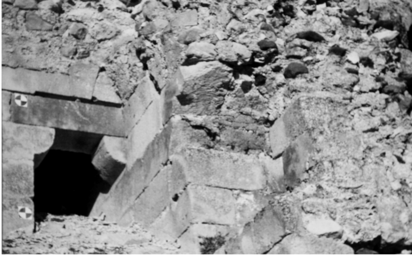
Şekil 11: 2. Kule giriş kapısı (U. Bilgiç 2007)
