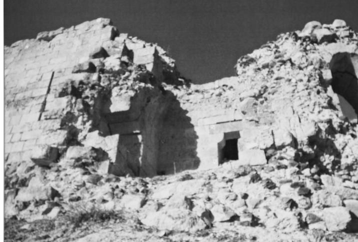
Şekil 10: 2. Kule kuzey cephe (U. Bilgiç 2007)
