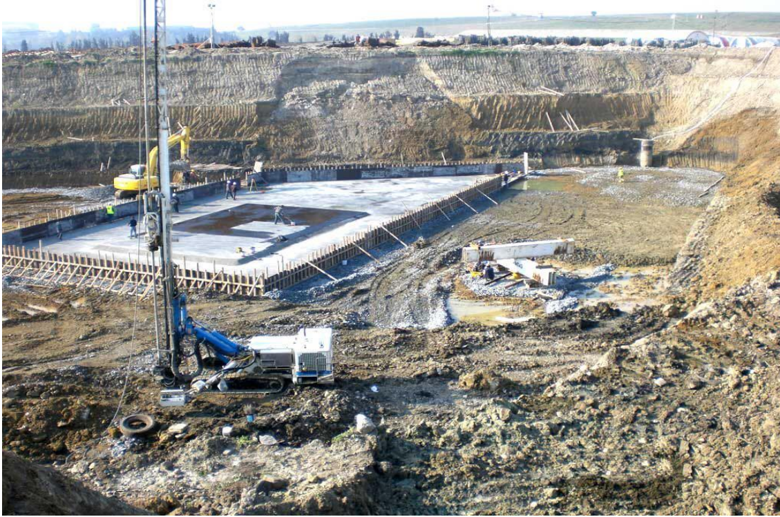
Şekil 4. Jet grout kolonları imalatı ve yükleme deneyi (Jet grout columns manufacturing and loading test)
