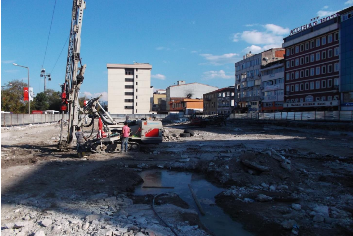
Şekil 5. Jet grout uygulaması(Jet grout application)
