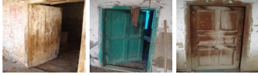
Şekil 17. Araştırma alanından farklı kapı örnekleri
