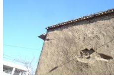
Şekil 28. Yetersiz saçak çıkmaları ve hasara uğramış sıvalar
