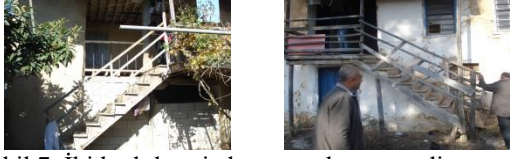
Şekil 7. İki katlı kerpiç konutta ahşap merdiven. Konutlarda sofa kullanımı çok amaçlı olduğundan, sofaların genişletilmesi yoluna gidilmiştir.
