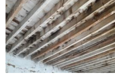
Şekil 14. Ahşap kiriş ve tahta kaplamalı tavan
