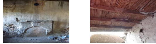
Şekil 23. Soba için baca deliği
