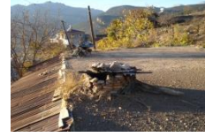
Şekil 24. Damda inşa edilmiş baca
