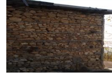
Şekil 15. Konutlarda yatay ve düşey hatıllar
