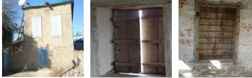
Şekil 18. kerpiç konutta kepenkler ve tam kasalı ve kepenkli pencereler
