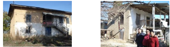
Şekil 25. Toprak harcı ile sıvalı evler
