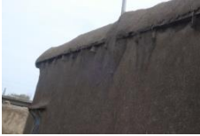
Şekil 28. Yetersiz saçak çıkmaları ve hasara uğramış sıvalar
