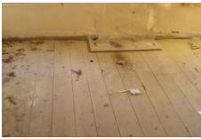
Şekil 13. Tahta kaplanmış avlu ve iç mekan
