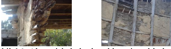
Şekil 16. Ahşap iskeletle desteklenmiş çalılarla oluşturulan duvarlar
