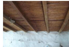
Şekil 10. Ahşap kiriş üzerine kamış kaplama tavan
