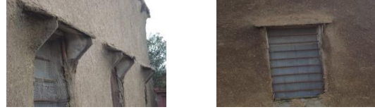
Şekil 19. Pencerenin korunması amaçlı saçak
