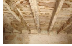
Şekil 14. Ahşap kiriş ve tahta kaplamalı tavan
