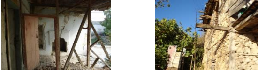
Şekil 20. Taş ve ahşabın birlikte kullanıldığı konut örneği
