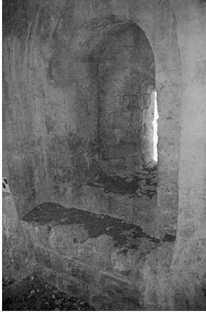
Şekil 5: Giriş mekanındaki mazgal pencere (B. Işık 2006)
