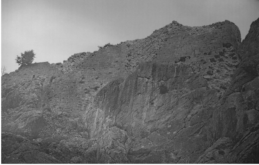
Şekil 11: Doğu cephesi (B. Işık 2006)
