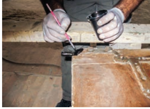
Şekil 24, 25. Metal elemanların tutunma gücü yüksek olan Hammerite boya ile boyanması
