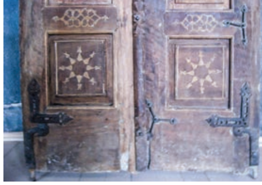
Sekil 18, 19. Kapı kanatları üzerindeki metal elemanlarda oluşan korozyon
