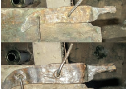
Sekil 22, 23. Metal elemanların dişçi motoru ile temizlenmesi
