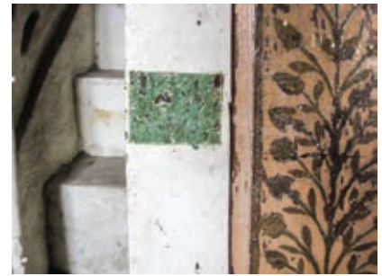
Şekil 11, 12. Desenlerin olduğu ve olmadığı bölümlerdeki boya katmanları
