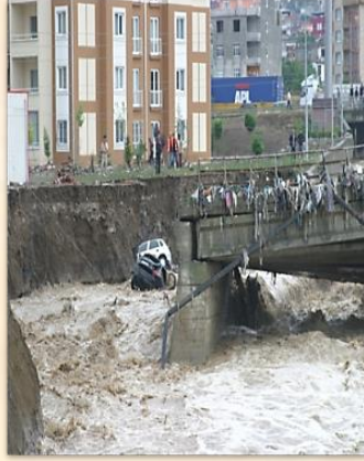
Şekil 4. 2012 yılında meydana gelen Mert Irmağı ve Yılanlıdere taşkını
