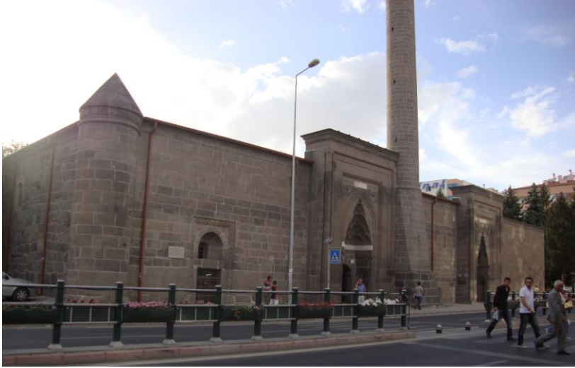
Fotoğraf 6. Kayseri Hacı Kılıç Camisi- Medrese, Doğu Cephe
