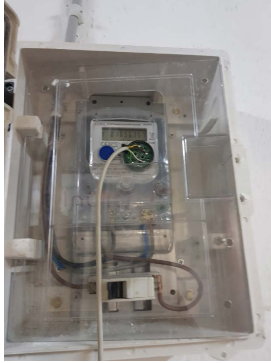
Şekil 6. Elektrik sayacına optik okuyucunun takılması
