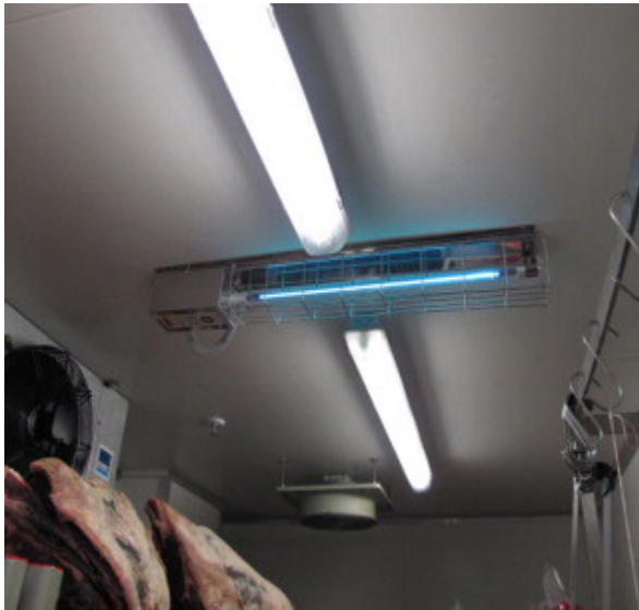
Şekil 2: Kuru olgunlaştırmada UV kullanımı (Perry,2012)
